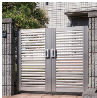
門扉等の支柱の固定
