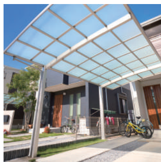
カーポート支柱の固定
