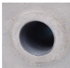
配管工事後の埋め戻し補修④
