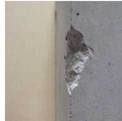
コンクリート壁面欠損補修①
