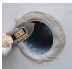
配管工事後の埋め戻し補修③
