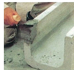
コンクリート 2 次製品補修③
