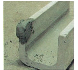
コンクリート2次製品補修②
