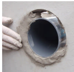
配管工事後の埋め戻し補修②
