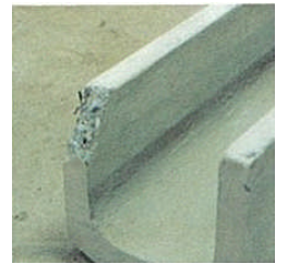
コンクリート2次製品補修①
