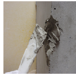
コンクリート壁面欠損補修②
