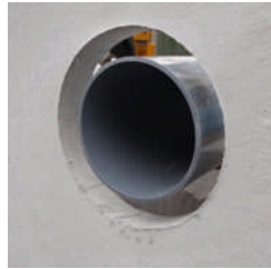
配管工事後の埋め戻し補修①
