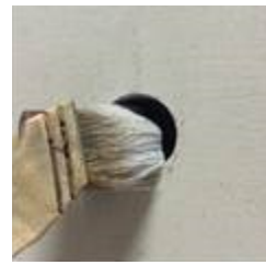
防錆剤の塗布（必要な場合）
