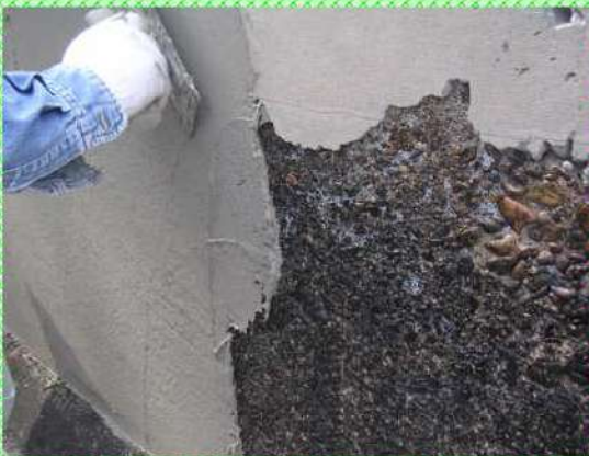
3. モルタル下塗り状況
