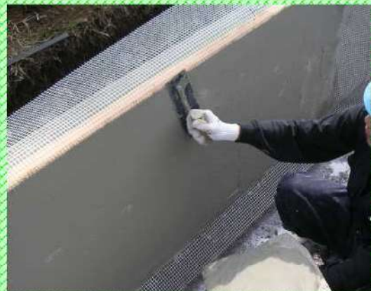
4. ネット貼付け・モルタル上塗り状況
