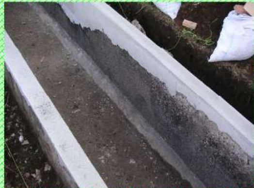
2. 天端断面修復後
