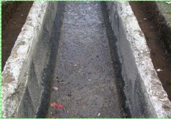
1. 施工前(天端ハツリ後)
